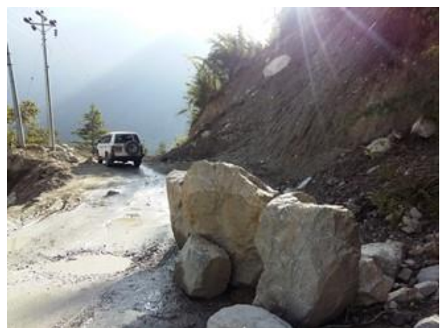
Abb. 1: Schäden an den Wegen und Straßenzugängen entlang in Mustang führen zu indirekter Betroffenheit der touristischen Akteur:innen (Foto: E. Posch 2018)
