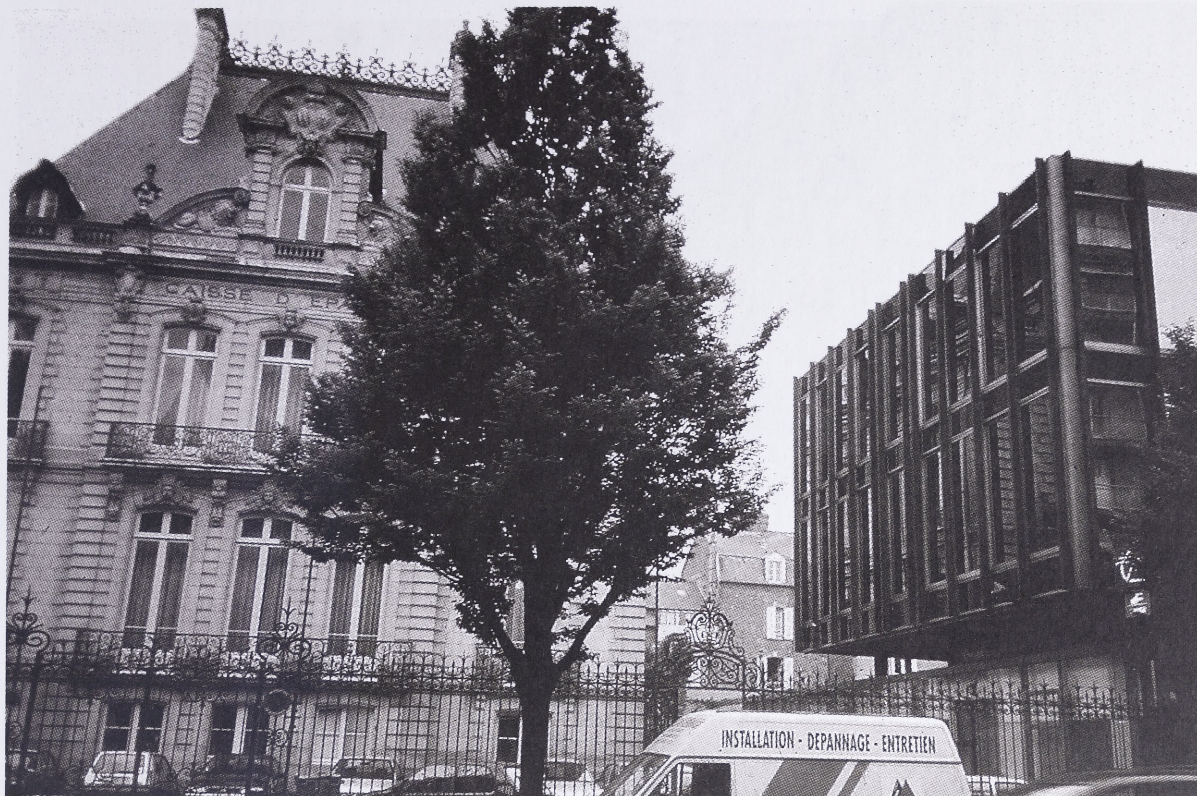
雷恩：這是一個失敗的實例。緊挨著一座19世紀的老樓，60年代建成了一座新樓，作為當時現代化的象徵，新樓採用高腳柱基和深色玻璃外牆，與周圍的建築物極不相稱。(Fig. 4)
