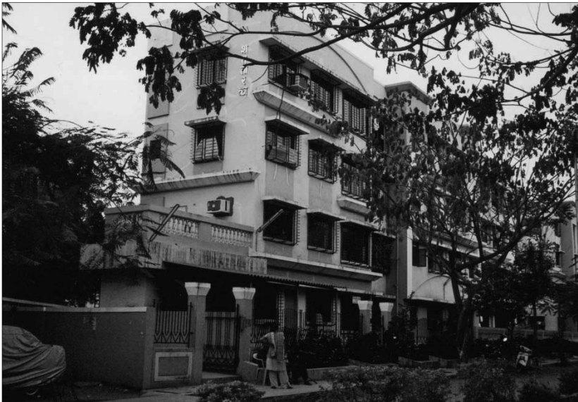
Abb. 8: Wohnanlage für Familien der Mittelschicht, Virar Ost
