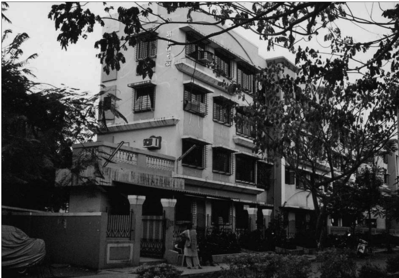
Abb. 8: Wohnanlage für Familien der Mittelschicht, Virar Ost
