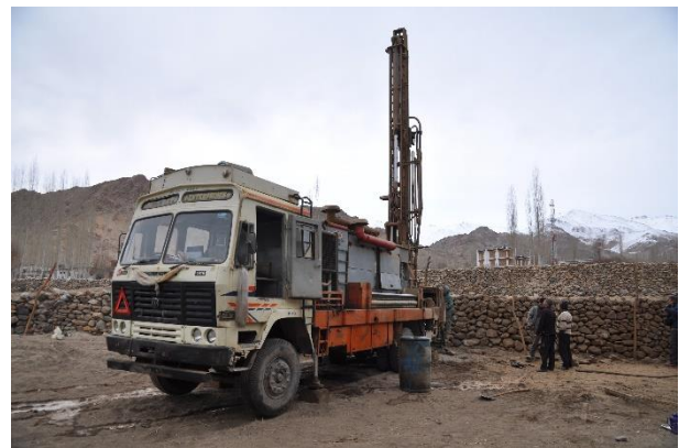
Abb. 2: Bohrung eines Grundwasserbrunnens auf Privatgrundstück (Foto: J. Müller 2015)
