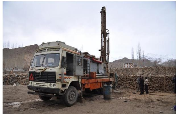
Abb. 2: Bohrung eines Grundwasserbrunnens auf Privatgrundstück (Foto: J. Müller 2015)
