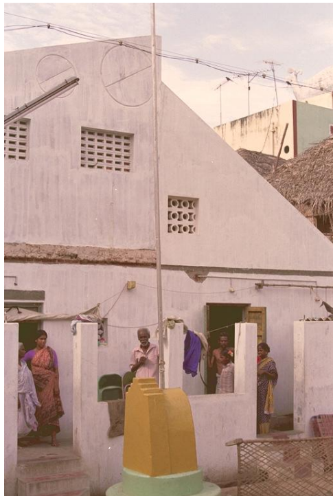
Abb. 1: Wohnhaus und Werkstatt, Foto: Norbert Beyer
