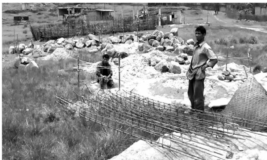
Wohnhauskonstruktion im Weiler Domiasiat (20 Kilometer entfernt vom Dorf Nongbahjynrim, Meghalaya) in Sichtweite eines mit Uran verseuchten Bohrlochs.
