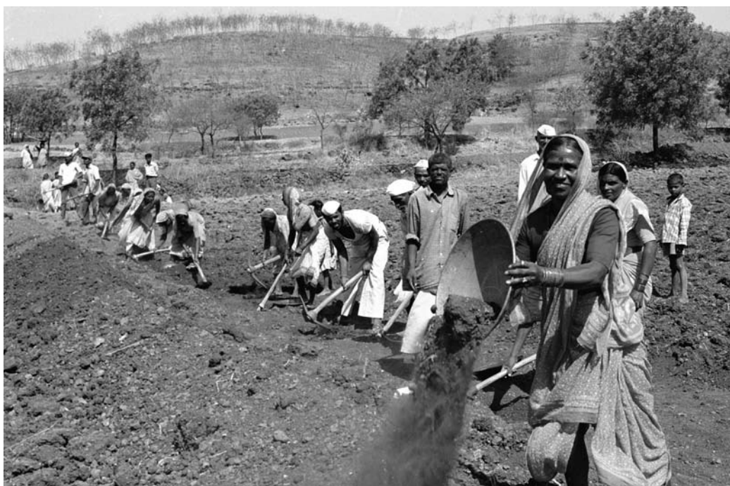
Bauern in Maharashtra verrichten Erdarbeiten zum sogenannten Wasserernten. Mit deutscher finanzieller und technischer Unterstützung hat das in Ahmednagar stationierte WOTR-Institut diese partizipatorische Form der Bewässerung in Dürregebieten populär gemacht.
