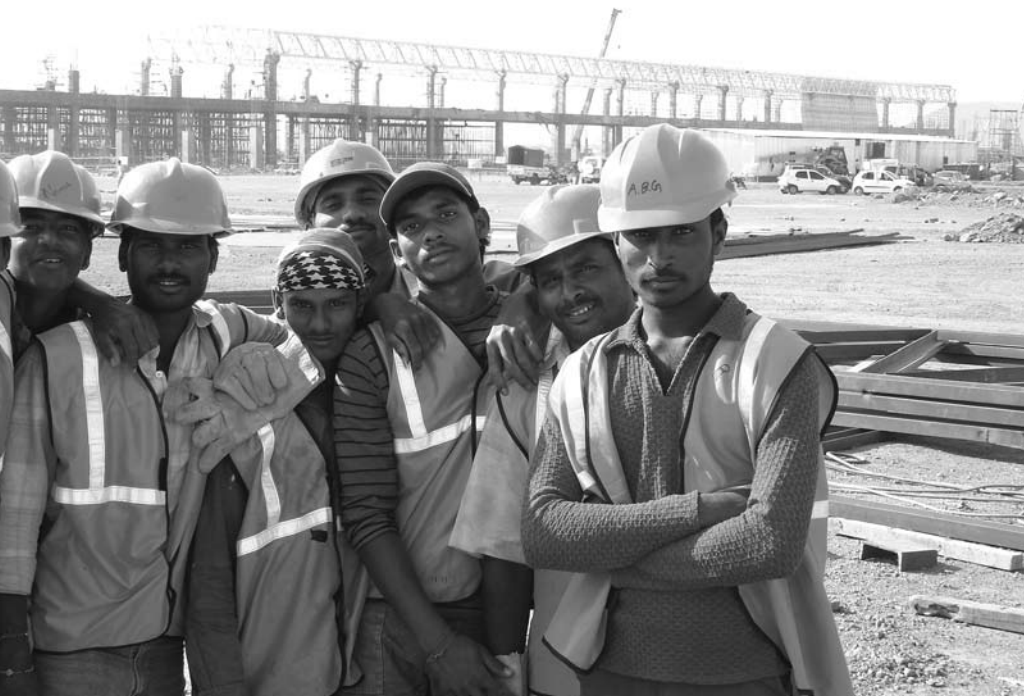
Arbeiter, die das neue Volkswagen-Werk in Pune bauten.
