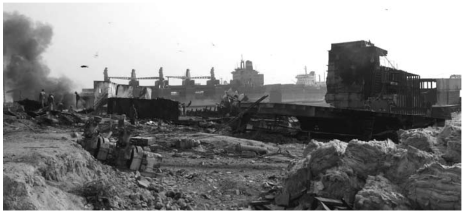
Abwrackarbeiten in Chittagong.
