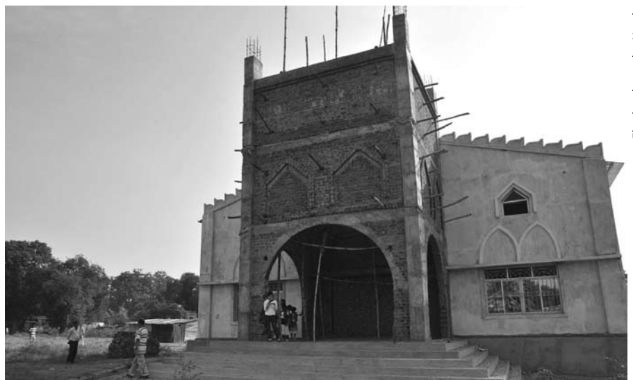
Der Neubau der Kirche in Nowrangpur soll bis Weihnachten fertig werden. Mitglieder der Gemeinde heben hervor: „Gerade jetzt ist dies für uns ein Zeichen unseres Glaubens und der Hoffnung.“
