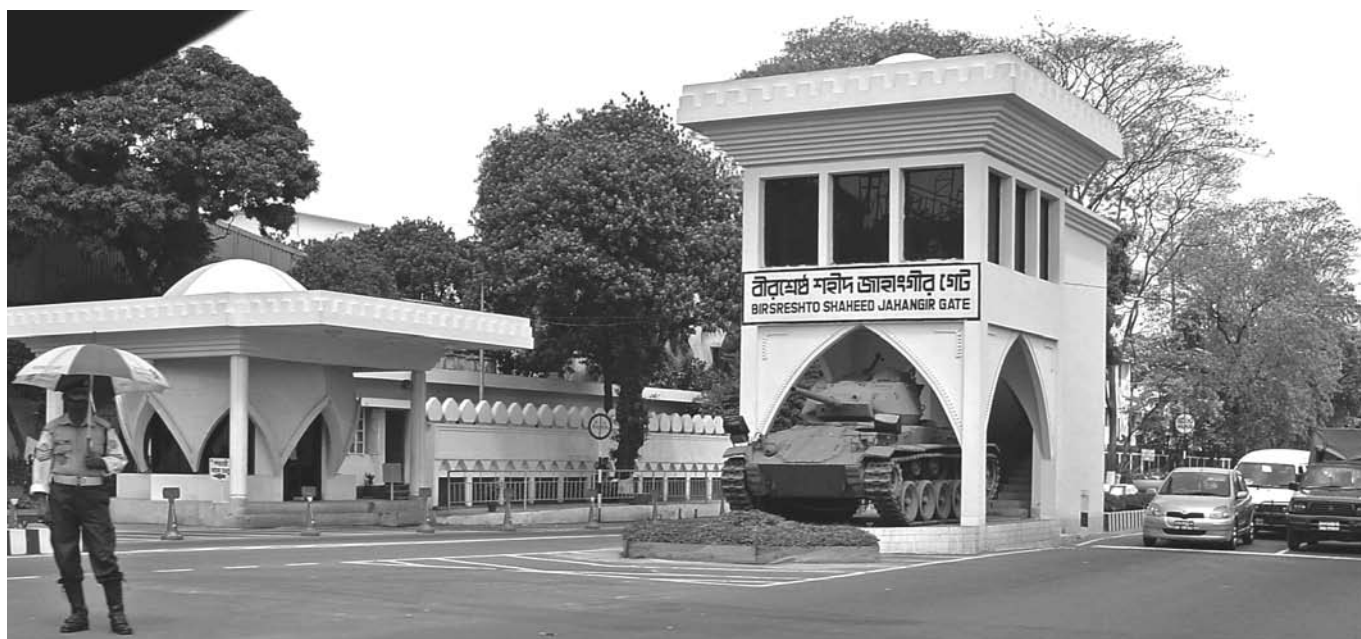
Zugang zur Macht? Das Birsreshtho Shaheed Jahangir Gate , ein Eingangstor in das Armeeviertel von Dhaka
