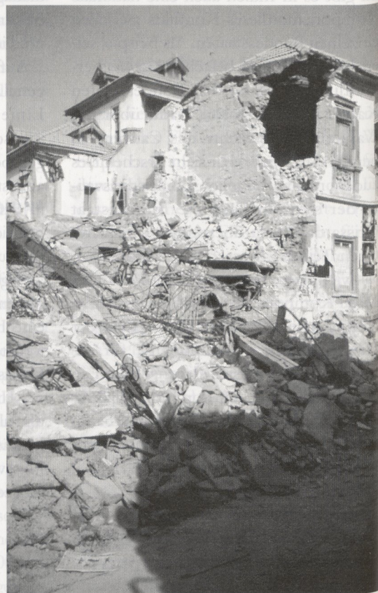
Zerstörte Häuser in Bhuj (Foto: Georg Amshoff)
