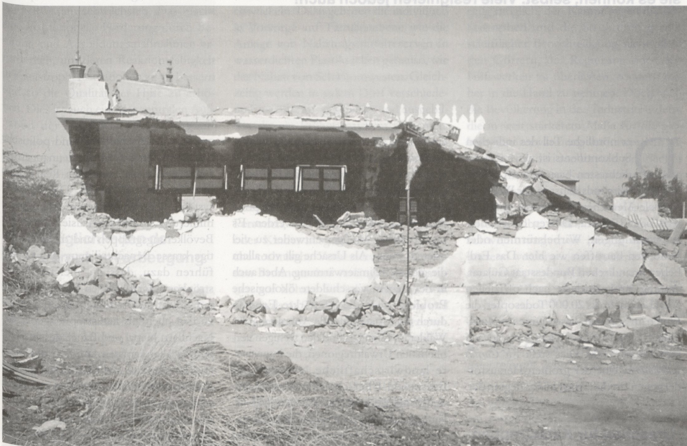
Zerstörter Neubau bei Bhuj (Foto: Georg Amshoff)
