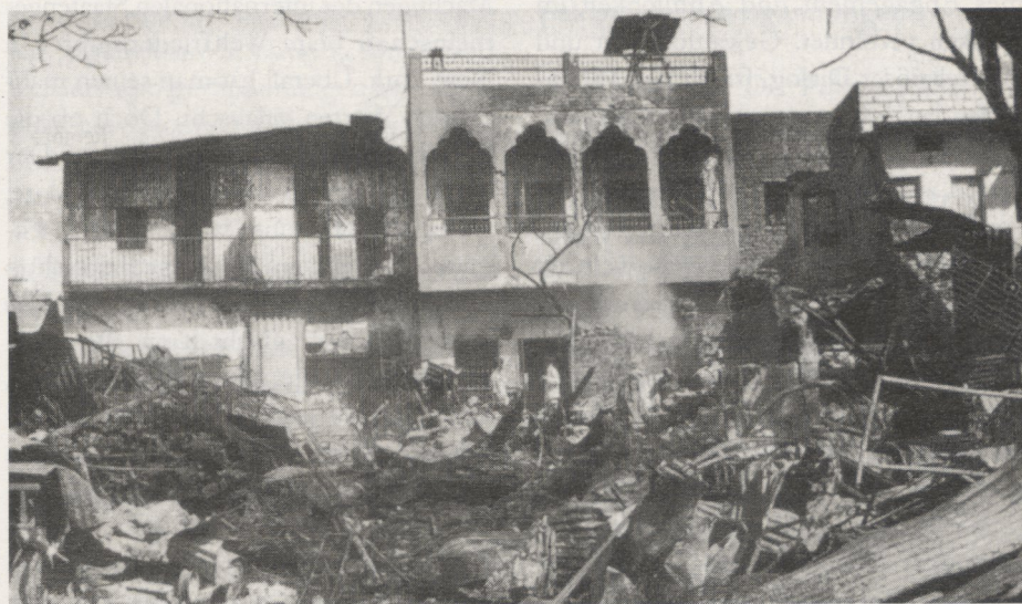
Verbrannte Erde: Zerstörte Muslim-Häuser in Naroda/Ahmedabad (Foto: Outlook)
