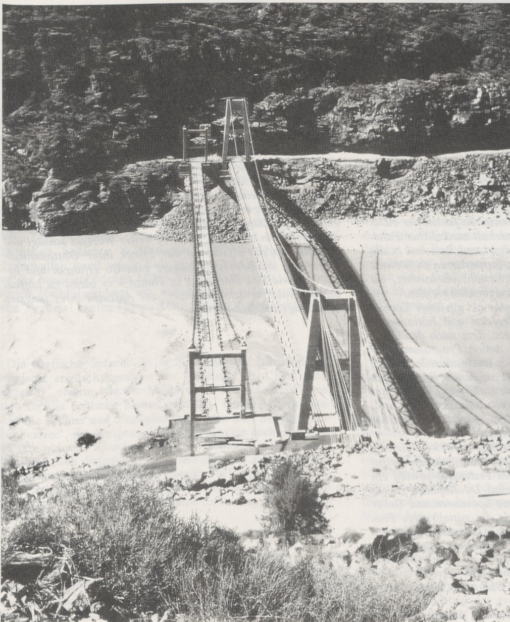
Brücken erschließen Seitentäler entlang des 'Karakorum Highway'.
