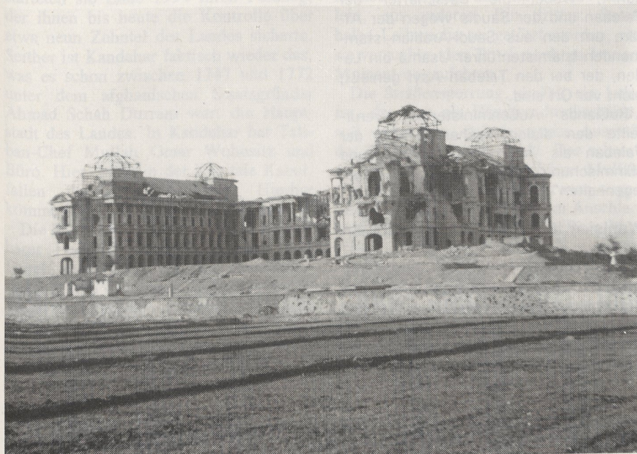
Zersörungen sind in Afghanistan allgegenwärtig, hier der zerstörte fühere Königspalast Dar-ul-Aman (Foto: Thomas Ruttig)
