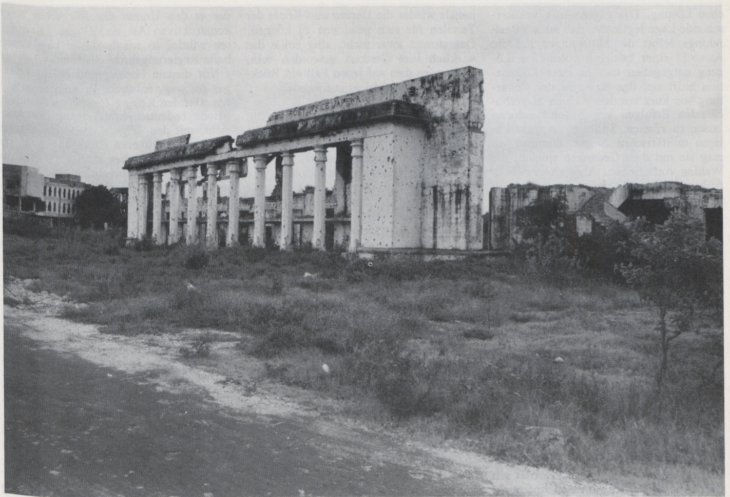
Die Art und Weise, wie der Krieg geführt wird, hat den Ruf Kumaratungas schwer beschädigt. Dazu haben u. a. auch die vielen Bombardements beigetragen, die in vielen Landesteilen zu starken Verwüstungen geführt haben. Hier das ehemalige Hauptpostgebäude in Jaffna (Foto: Walter Keller)
