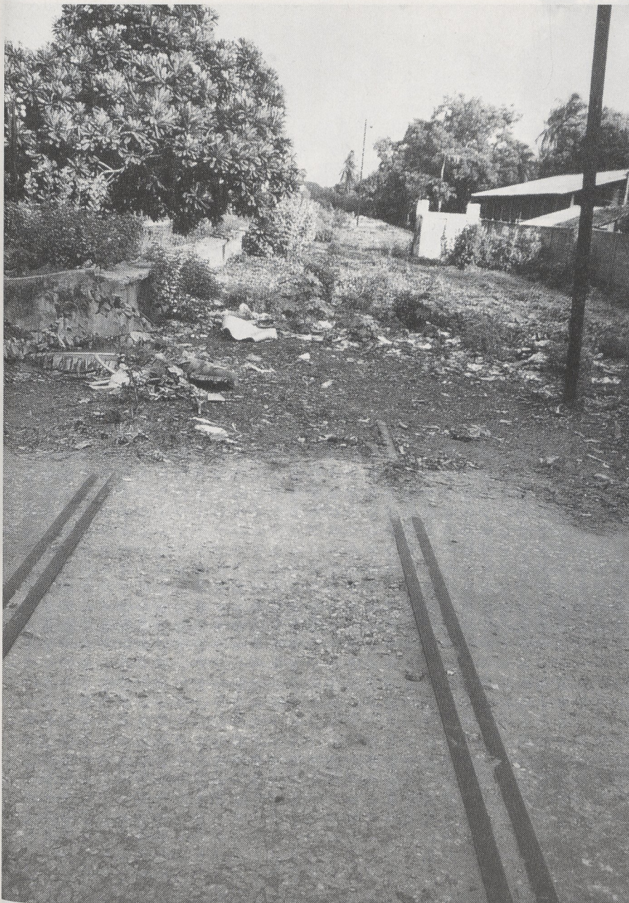
Eisenbahngleise enden im Nichts. Schon vor Jahren wurden Schienen und Schwellen zum Bunkerbau verwendet.
