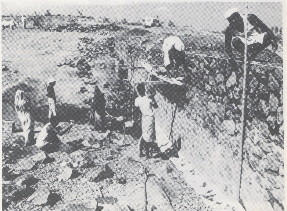
Bau von Kleinst-Wasserspeicherbecken als Stauwehr (Foto: 'Kreditanstalt für Wiederaufbau')
