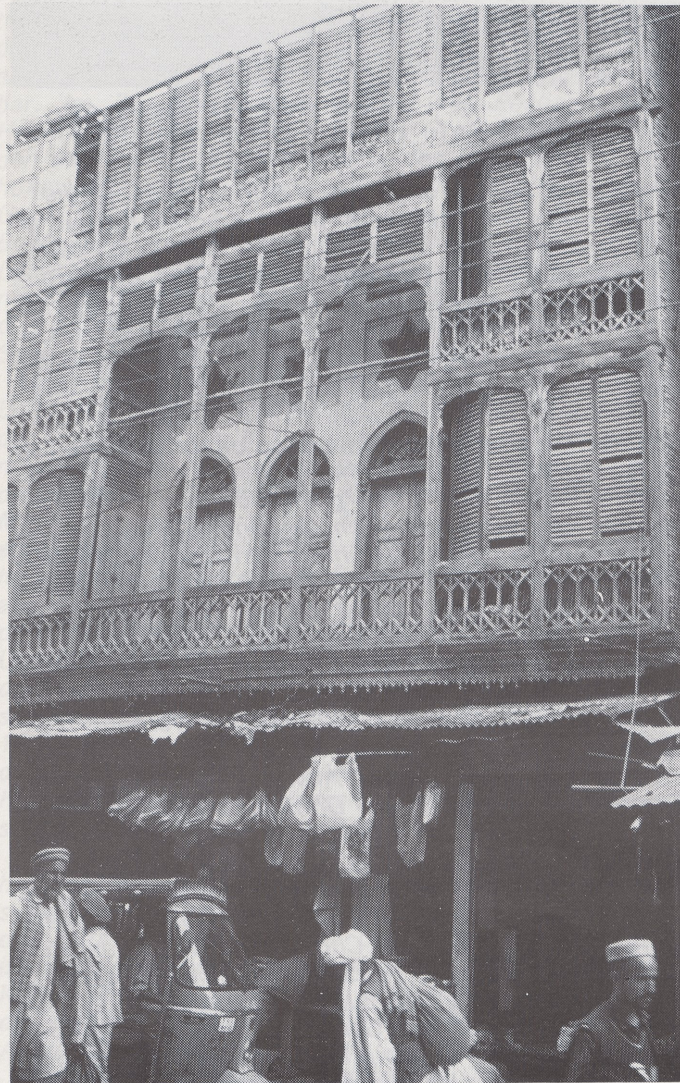
Alte Hausfassade in der Altstadt von Peshawar (Foto: Christian Berndsen)
