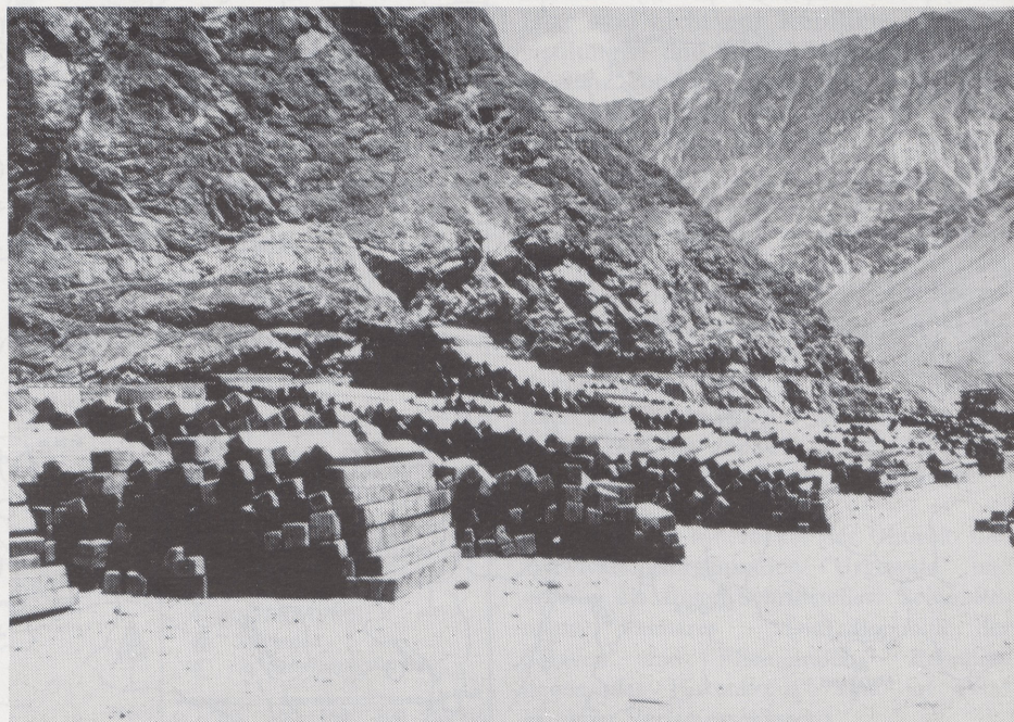
Holzlagerplatz am Karakorum Highway nahe der Raikot-Brücke
