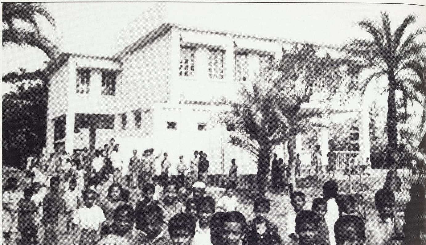
Eine Schule mit Zyklonschutzfunktion - Die EU rüstet zusammen mit Deutschland und Spanien im Rahmen des 'Primary-School-cum-Cyclone-Shelter' Projekts Schulen auf.
