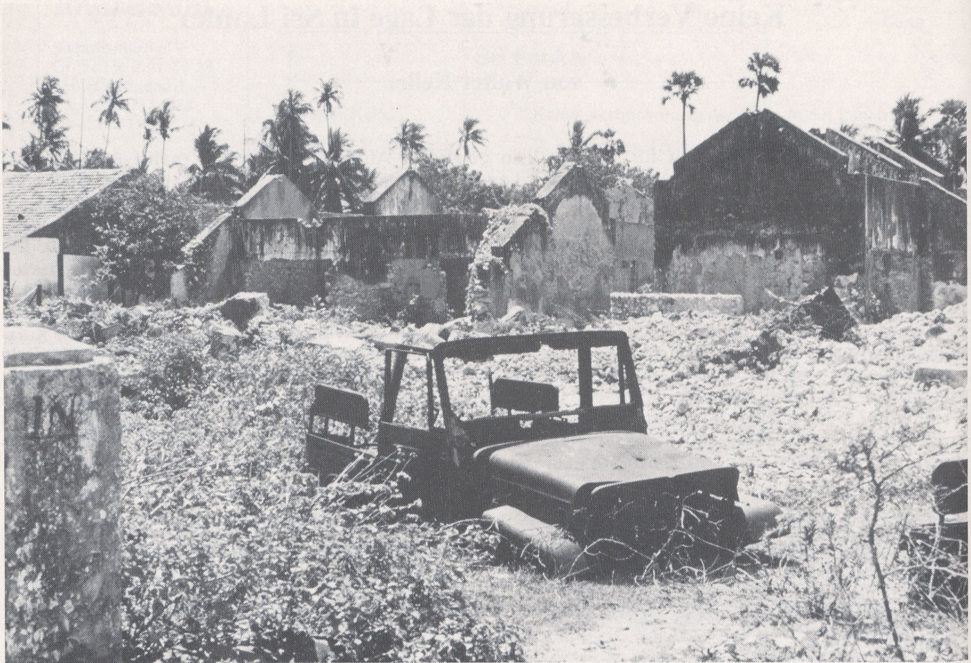
Zerstörungen auf der Jaffna-Halbinsel (Foto: Michael Mertsch)
