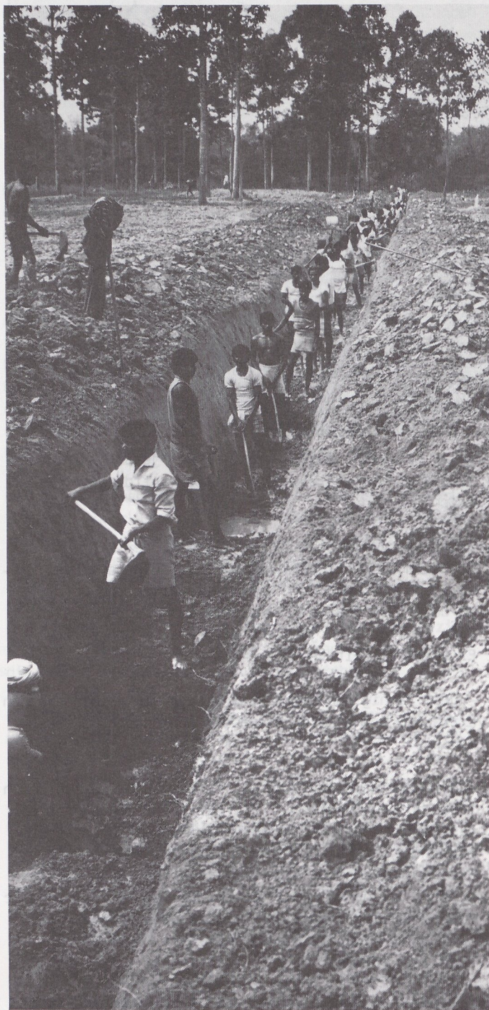
Arbeiter beim Ausheben einer Drainage
