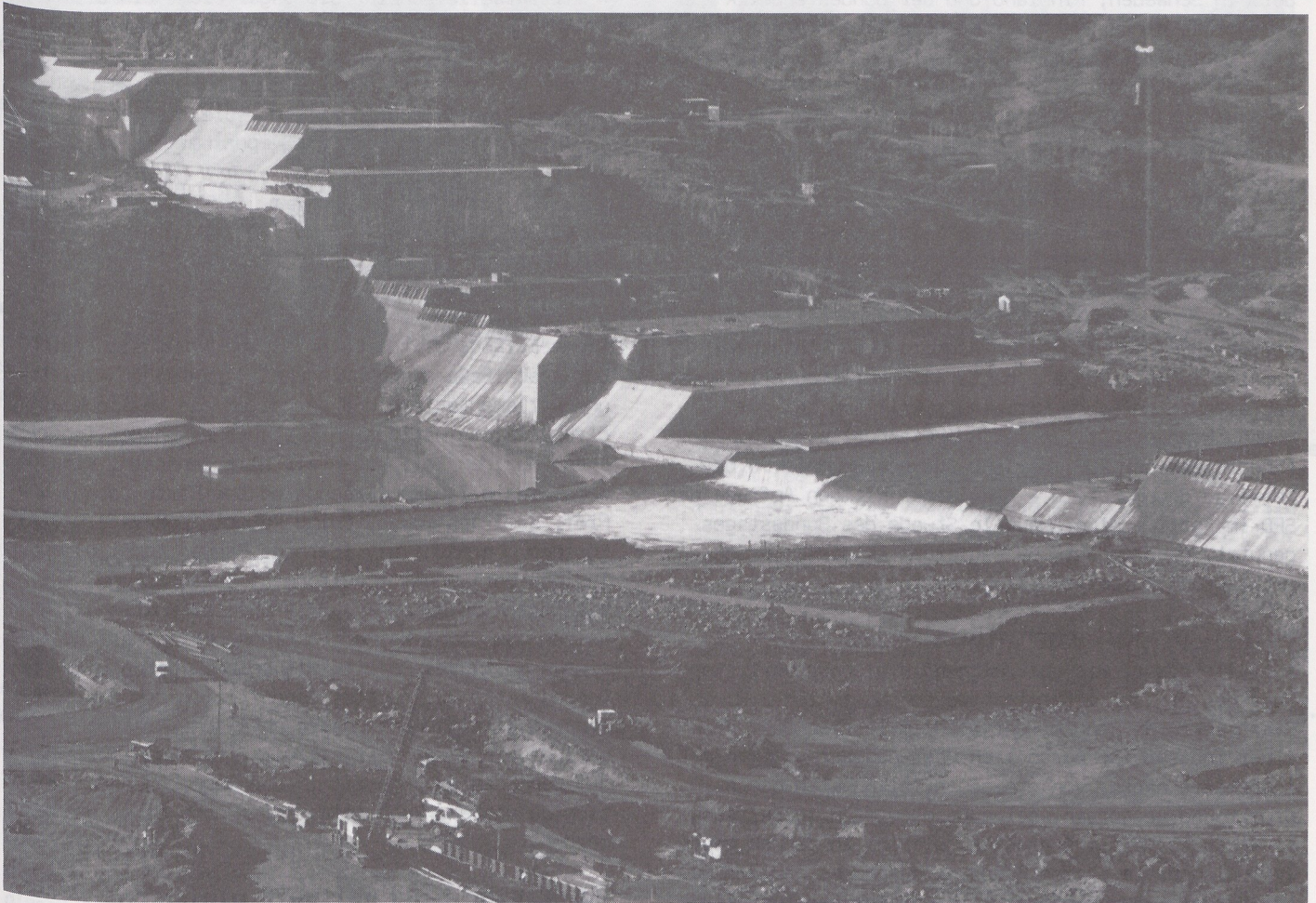
Baustelle des Sardar Sarovar Staudamm-Projekts am Narmada Fluß (Foto: Axel Krause/Laif)
