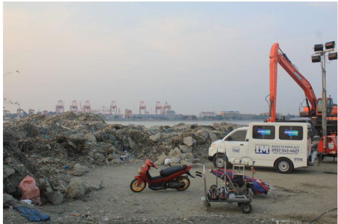
Eine Baustelle an der Manila Bay im Baseco Compound. Der Baseco Compound liegt in Sichtweite des Port of Manila, einer der größten und wichtigsten internationalen Seehäfen der Philippinen © Mirjam Overhoff
