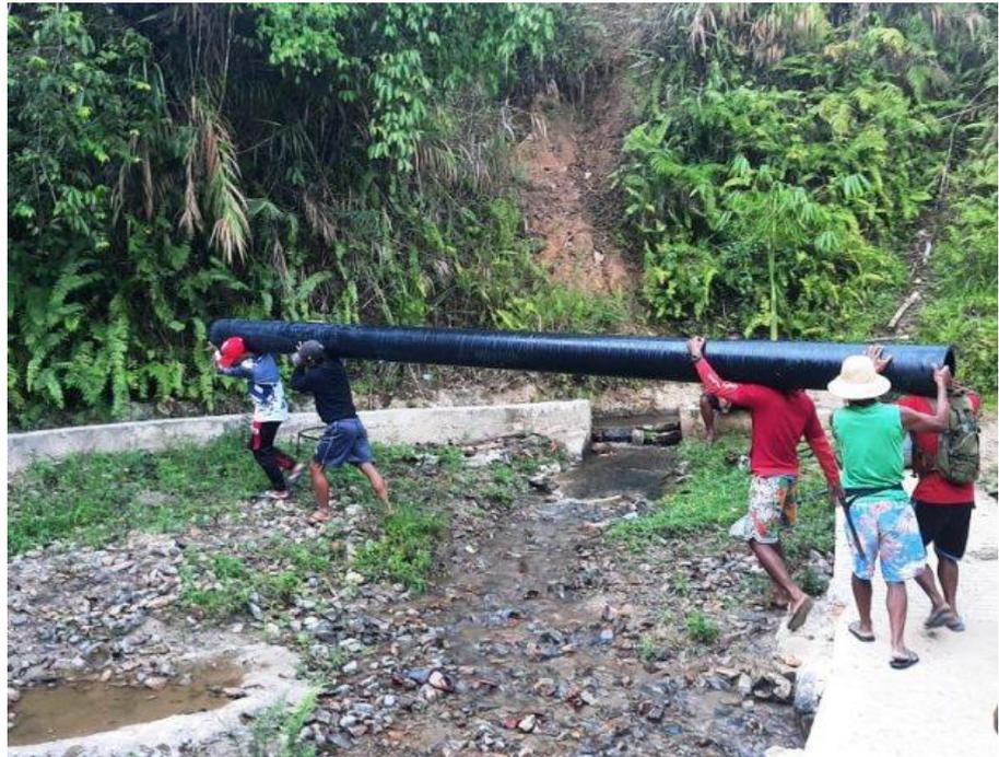
*Bewohner\*innen von Katablangan, Philippinen, errichten in Eigeninitiative ein Kleinwasserkraftwerk. Mit dem Rohr stellen sie die Verbindung zwischen einem Damm und dem Generator her. © J. Erasquin – SIBAT*
