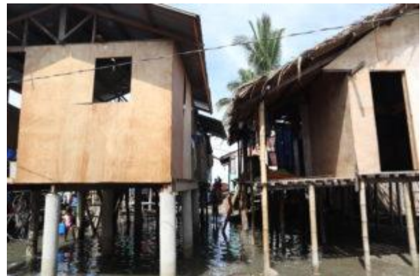
Sama Badjao bauen schrittweise ihre Häuser wieder auf, im Vergleich die alte Bambusstelzenbauweise vs. die neuen Betonstelzen. © Gretchen Gonzaga
