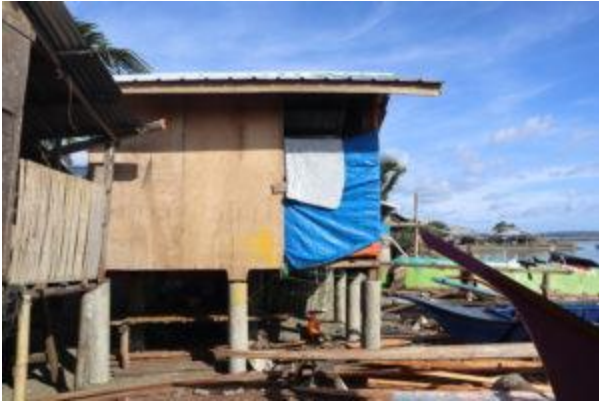
Sama Badjao bauen schrittweise ihre Häuser wieder auf, statt Bambuspfeiler werden Betonpfeiler gegossen. © Gretchen Gonzaga
