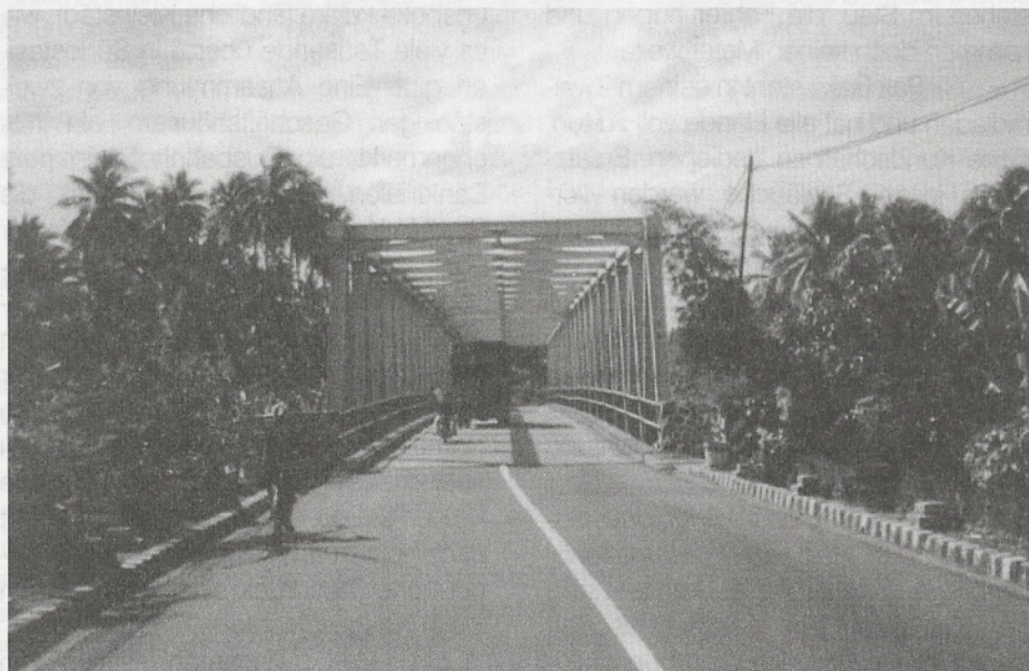
Die West-Pasaman-Verbindungsstraße: mit Mitteln der deutschen finanziellen Zusammenarbeit 1981 bis 1984 gebaut
