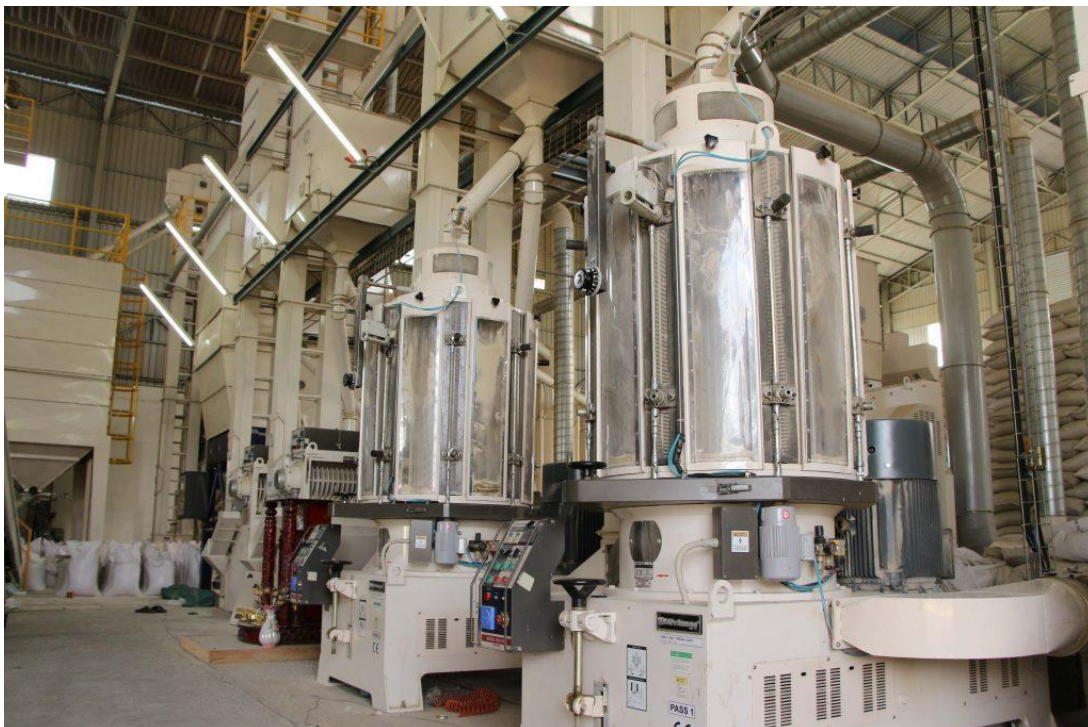
In Maschinen zur Reisverarbeitung wurde viel investiert. © AMRU RICE
