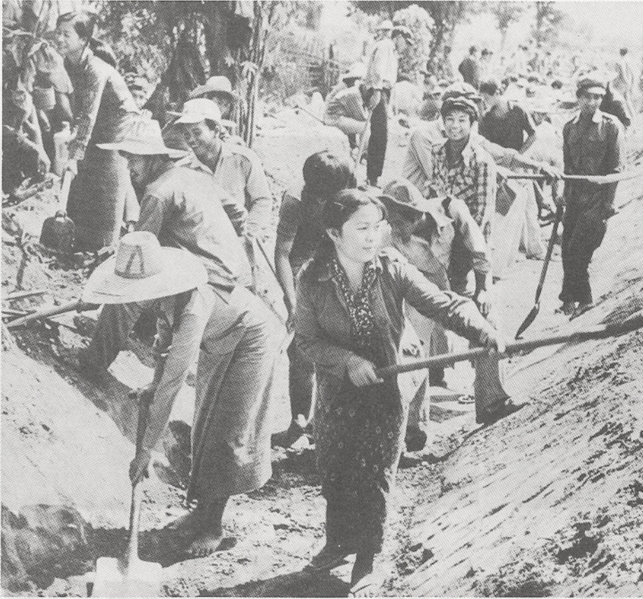
Ausgrabungsarbeiten für einen Kanal
