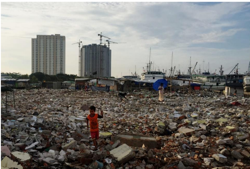
Oft müssen die Bewohner der Kampungs dem Bau neuer Superblocks weichen. Hier: die Trümmer des abgerissenen Kampung Pasar Ikan Penjarangan. Dessen Bewohner berichten, dass sie nur eine Woche vor dem Abriss ihrer Häuser benachrichtigt wurden. © Christ Bent
