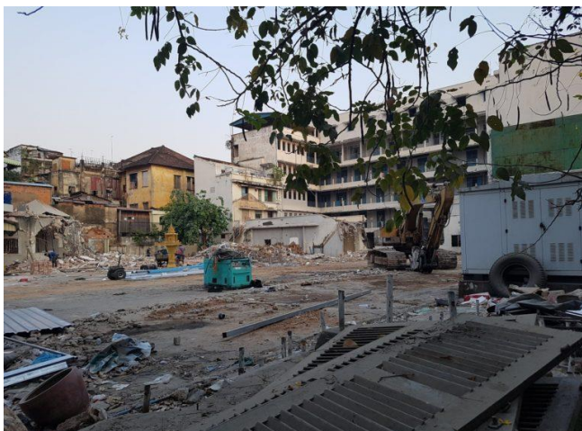
Im ganzen Stadtgebiet Phnom Penhs werden alte Wohnhäuser abgerissen und durch moderne Hochhäuser ersetzt. © Mech Dara
